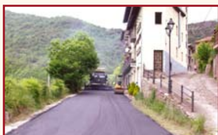
Millora paviment de la Plana de Mont-rós
