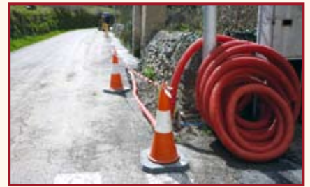
Adequació enllumenat la Torre de Capdella
