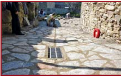
Urbanització carrers de Pobellà
