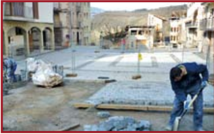
Urbanització integral carrer Major de La Pobleta
