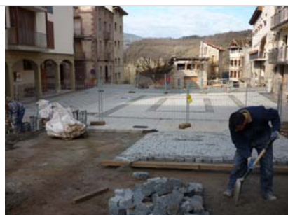
Urbanització integral carrer Major de La Pobleta
