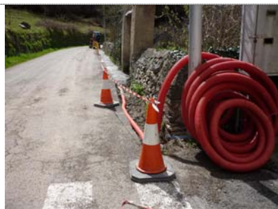
Adequació enllumenat la Torre de Capdella
