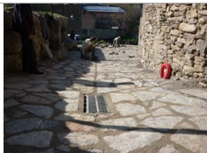
Urbanització carrers de Pobellà
