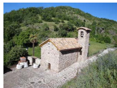
Restauració coberta església de Castell-estaó
