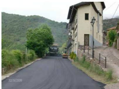
Millora paviment de la Plana de Mont-rós
